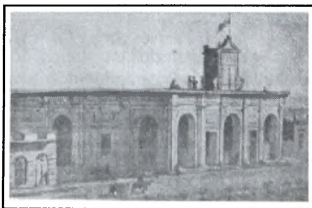
Fig 23 El templo en construcción.
